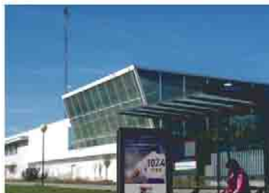
Vista del Centro de emisión y producción de Zaragoza
