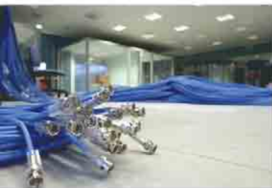
Estado de las obras del Centro de emisión y producción de Zaragoza
